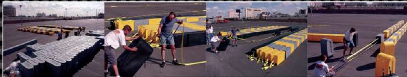
Installation d'une piste à Las Vegas, USA.
